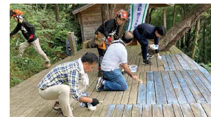
熱海市・熱海支部(2024.10.26) 熱海キコリーズと連携 ATAMI Green field/ウッドデッキの防腐剤塗布
